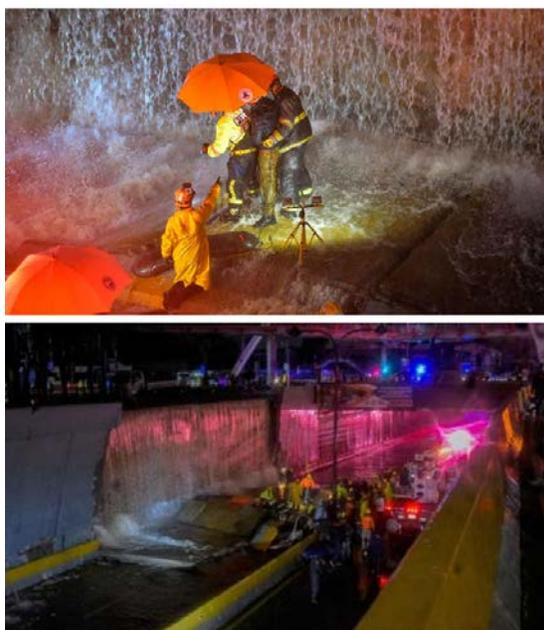
**Fig.12- Colapso de muro lateral en paso a desnivel en la ciudad capital.**
